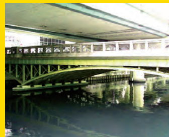
橋梁 D47仕上
