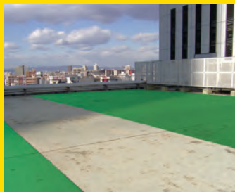
防水シート屋上 D42仕上
